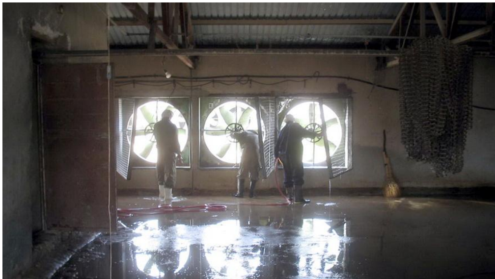
عملیات شستشوی هواکش ها
