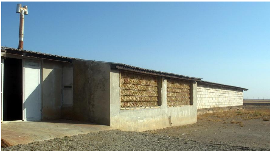
نمونه گالری کولینگ در یک سالن مرغداری
