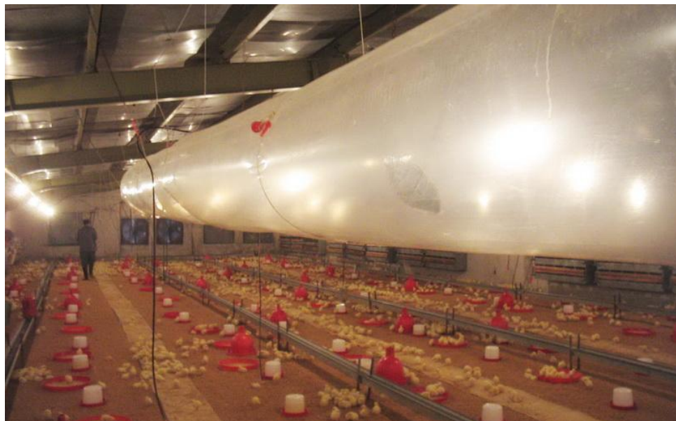
کانال هوای گرم و مرطوب در بالای سر جوجه ها
